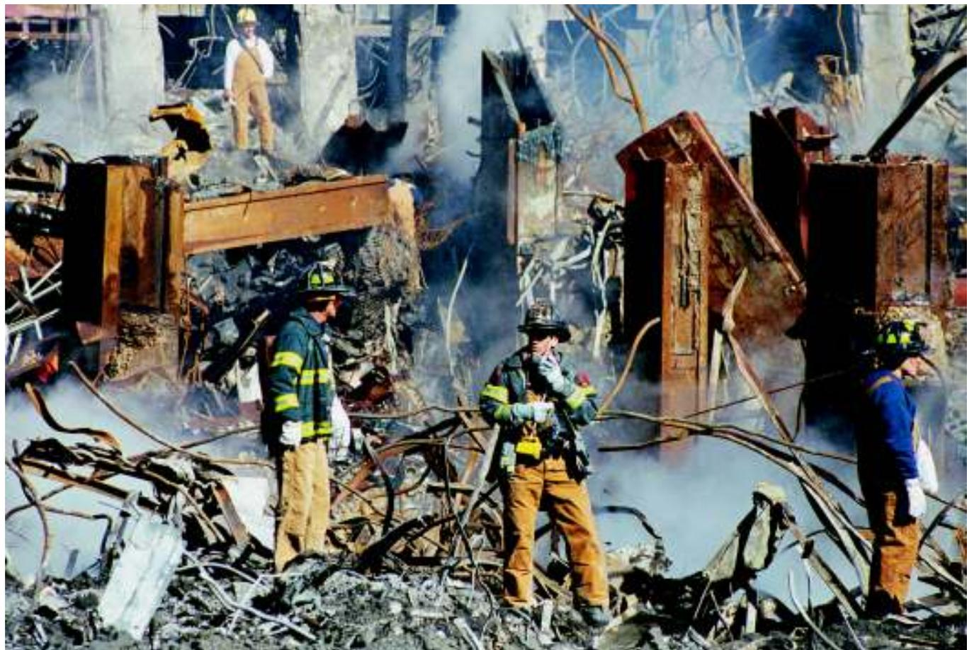
**Abbildung 3.5** Die Kernsäule in der Mitte des Bildes sieht aus, als wäre sie von einem Schneidbrenner durchtrennt worden. Die Arbeiter zerschneiden die Stahlteile so schnell, dass es schwer ist zu sagen, welcher Schaden von ihnen angerichtet wurde.
